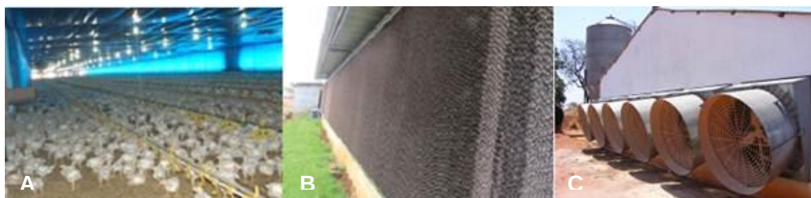
Figura 2. A) Vista interna, B) vista externa de instalação com Sistema Adiabático Evaporativo e C) Exaustores. Fonte: Avicultura Industrial. 3
