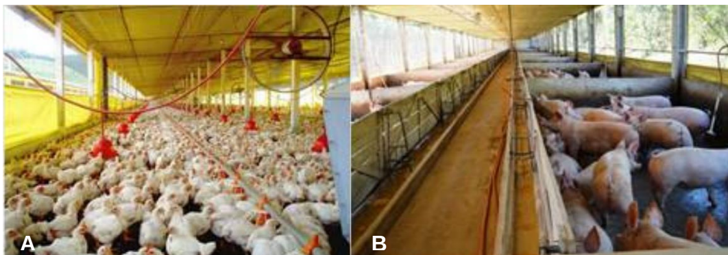
Figura 1. A) Vista interna de instalação Convencional de aves e B) vista interna de uma instalação do tipo Convencional para suínos. Fonte: A) Repositório Digital de Carlos Pena 1 e B) Portal Suínos e Aves 2 .
